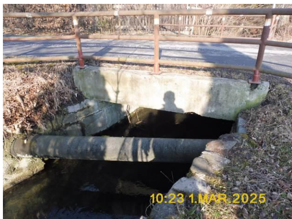
Pohled na vtok s vodovodem
