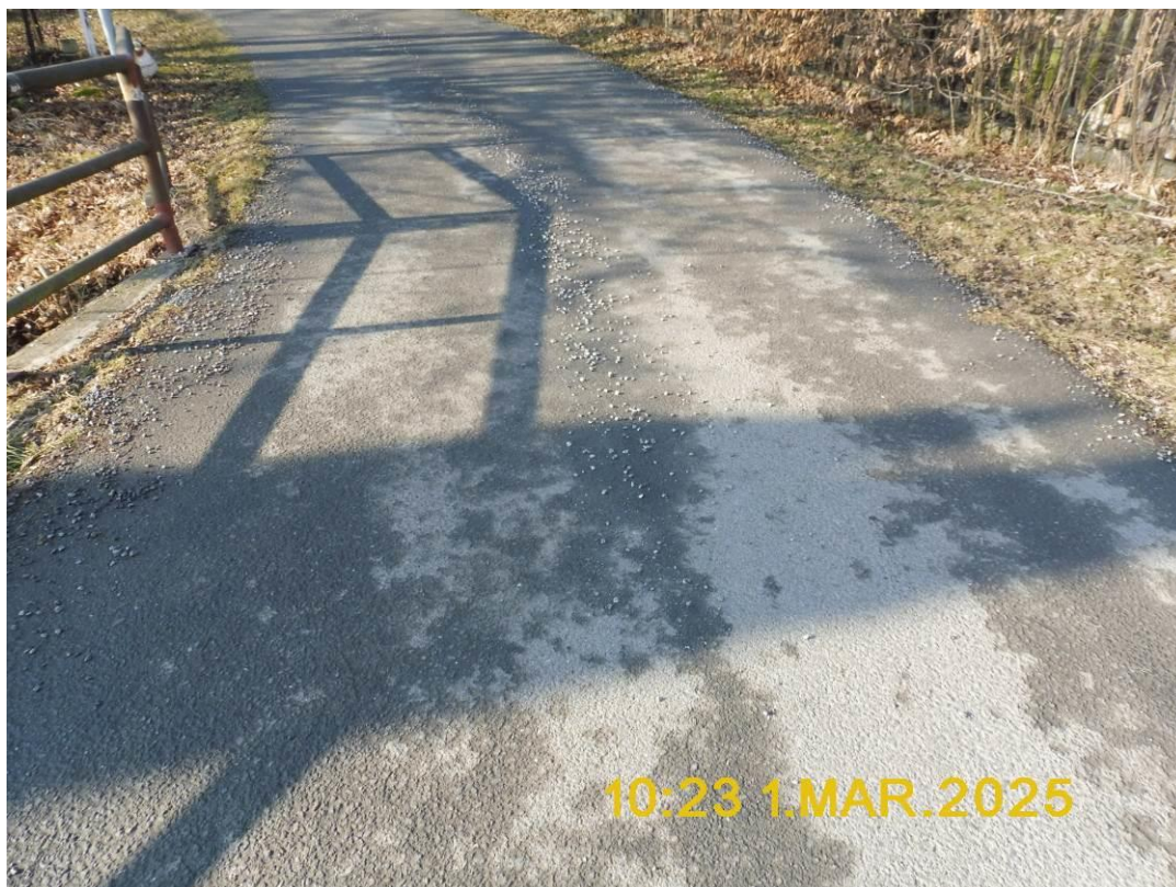
Pohled na most
