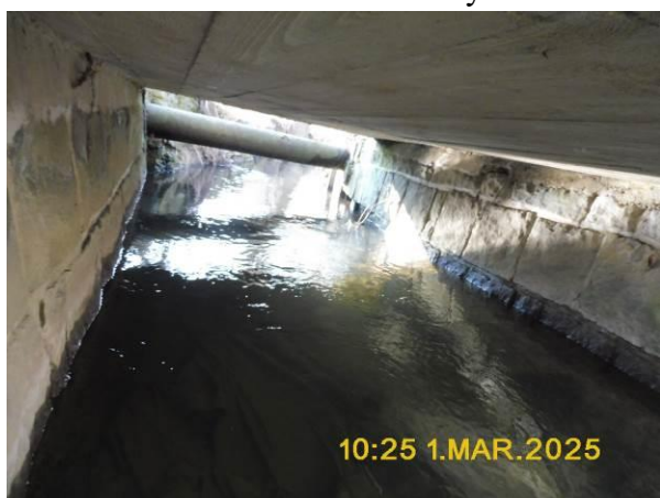
Podhled NK a opěra na LB
