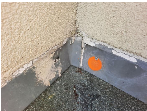
Obr. /21/ Detail oplechování svislého zakončení
