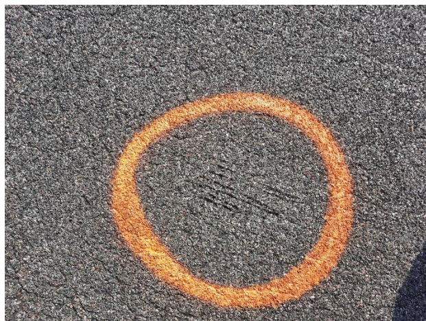
Obr. /7/ Kapilární poruchy a perforace
