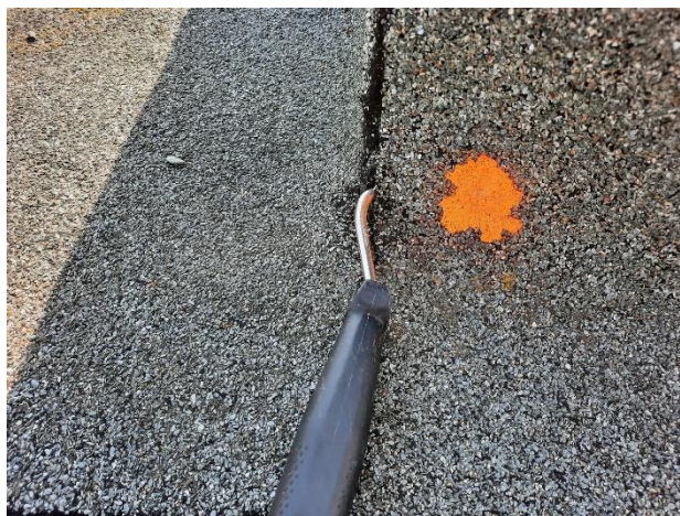
Obr. /8/ Separace tavných spojů
