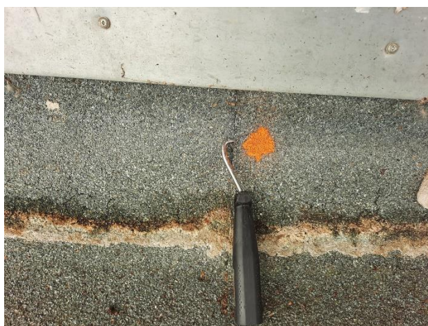
Obr. /20/ Separace tavných spojů
