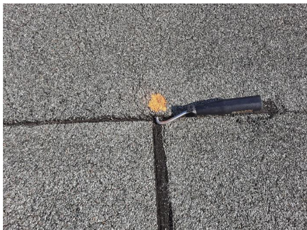
Obr. /10/ Separace tavných spojů
