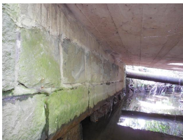
Chybějící kameny na opěře OP1
