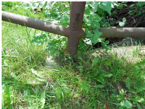
Chybějící kus zrezivělého zábradlí
