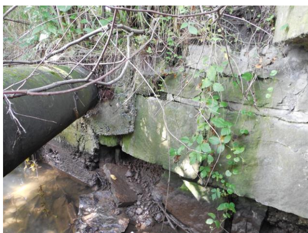
Rozvolněné kamenné bloky u OP2
