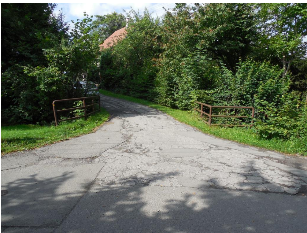
Pohled na most, zrezivělé nenormové zábradlí
