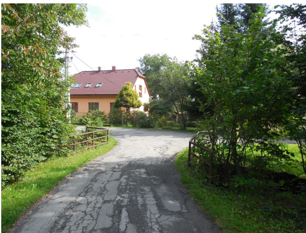
Pohled na most, zvětralá vozovky, vegetace na mostě
