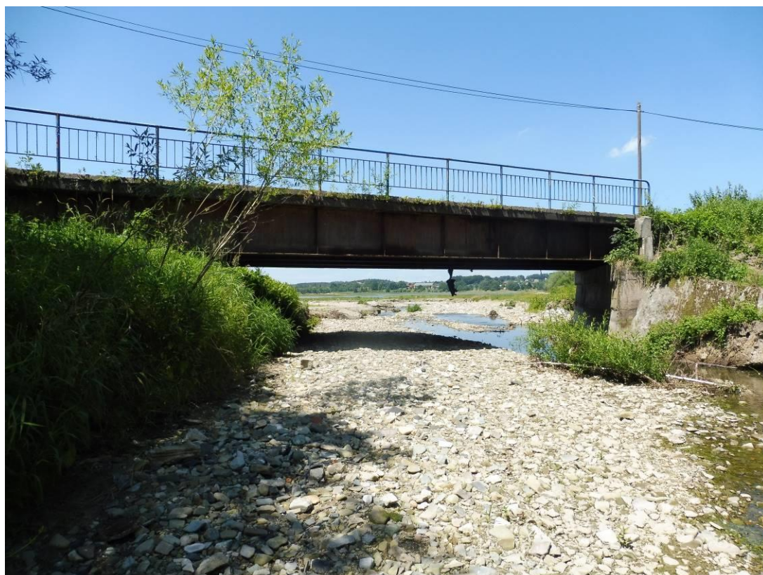
Pohled na most
