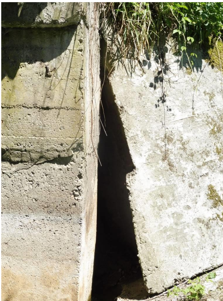
Rozevření dilatační škáry křídla
