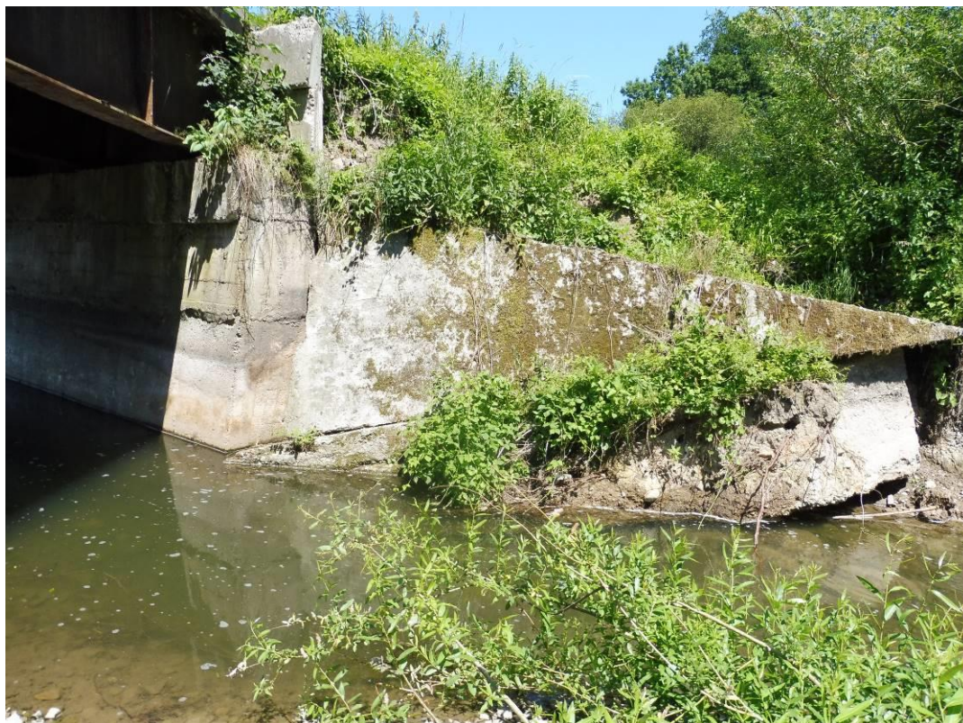
Sesunuté levé křídlo opěra 1
