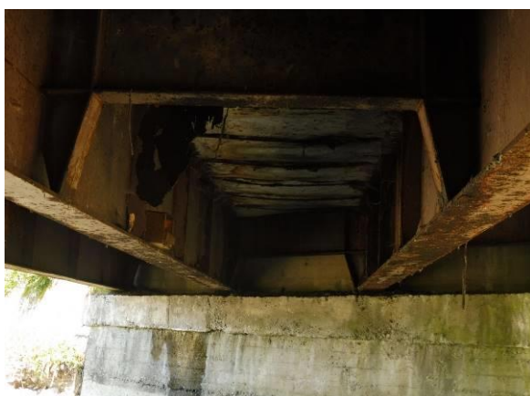
Podhled NK a pohled na OP1
