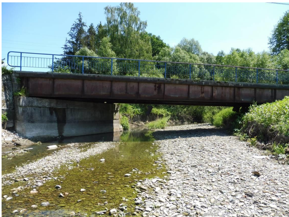
Pohled na most
