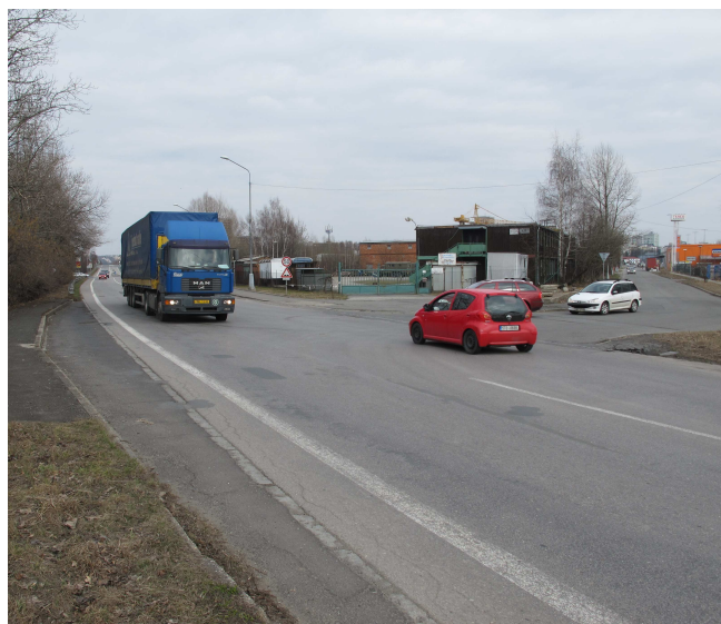
Obrázek 16.11: Křižovatka K24, značka P04 „dej přednost v jízdě“ je na ulici Collo-louky zakryta v letním období listy ze stromu (vlevo), do křižovatky je nevhodně zaústěna účelová komunikace (vpravo).
