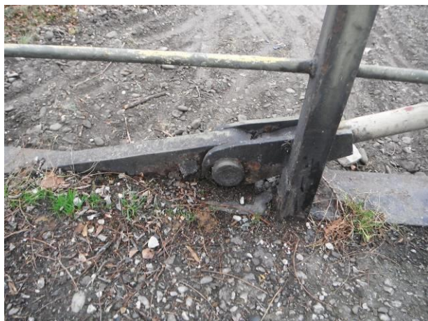
Kotvení a tyčové závěsy mají porušené PKO a jsou lokálně korodující i pod poškozeným ochranným nátěrem.
