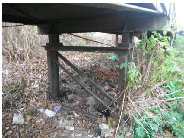
Pohled na P6, přesypáno kotvení sutí a nečistotami, vegetace.
