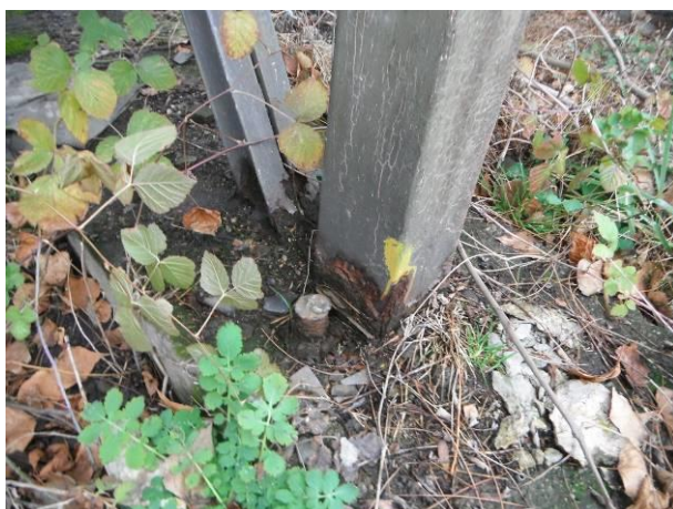
Pohled na P4, pravé kotvení. Značná lístková koroze v místě vetknutí podpěry do základu. Kotvení je částečně zasypáno – zvýšená vlhkost.
