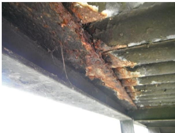
Detailní pohled - značná koroze na vnitřní straně vrchních přírub nosníků NK v místě styku s vlněným plechem (ztracené bednění mostovky) a příčným ztužením kam zatéká. Tento stav je téměř na celé lávce.
