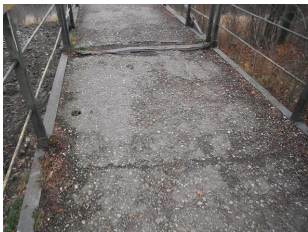
Po celé lávce jsou v betonovém chodníku nerovnoměrně příčné trhliny.
