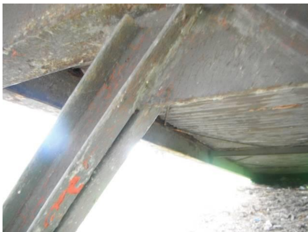
Pohled na P2, porucha PKO, koroze.
