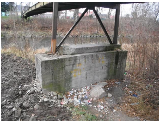
Pohled na základ a P3 z levého břehu od 3. pole. Obnažené pravé kotvení, obnažená korodující výztuž.
