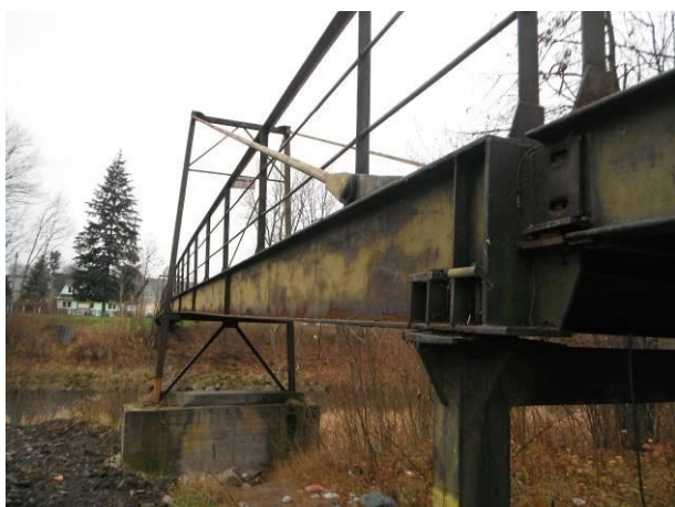
Pohled z pravé strany - v kloubovém napojení rampy na lávku chybí spojovací šrouby, koroze všech oc. prvků lávky.
