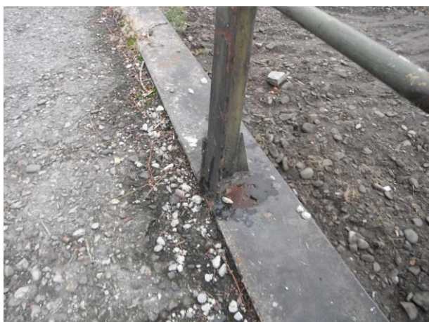
U kotvení zábradelních sloupků na nosník NK jsou nánosy nečistot a zvýšená vlhkost, v tomto místě je koroze výraznější.
