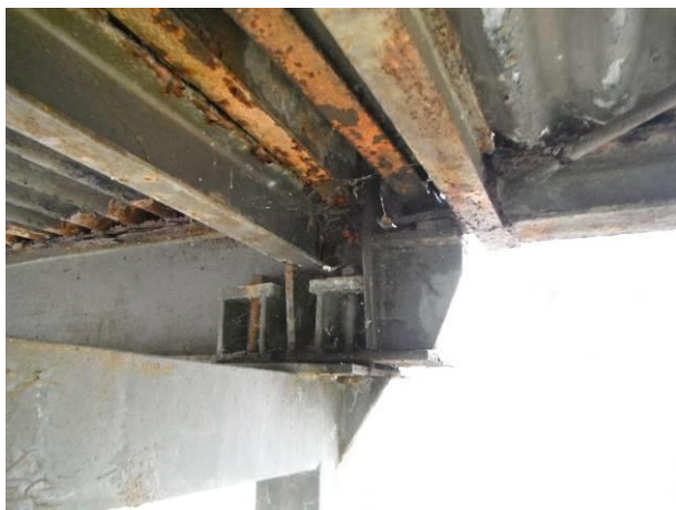
Pohled na P4 ze spodní strany, značná koroze pod poškozenou dilatací.
