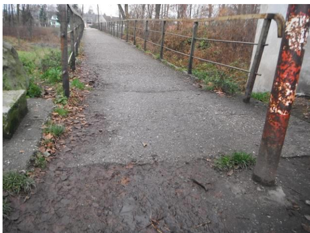
V předpolí lávky jsou nerovnosti a výtluky na navazujících pochozích plochách.
