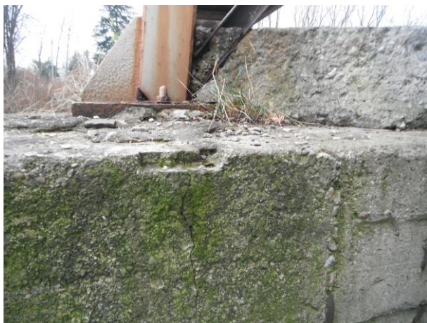
Detailní pohled na obnažené pravé kotvení z důvodu odtržení krycí dobetonávky základu. Koroze kotvicích prvků. Vertikální trhlina v základu (2 mm).
