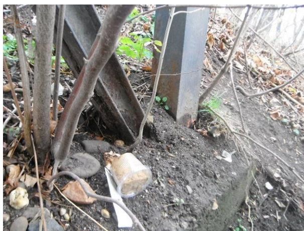
Pohled na P2, levé kotvení. Lístková koroze v místě vetknutí podpěry do základu. Kotvení je částečně zasypáno – zvýšená vlhkost.
