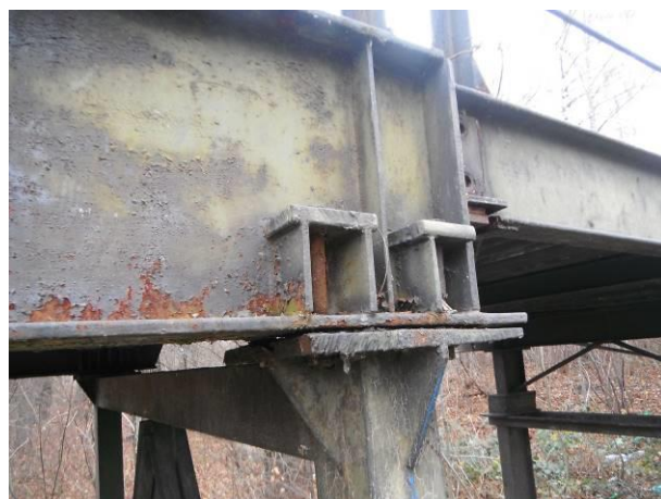
Pohled na pravou stranu P4, koroze ložiskových šroubů a plechů.
