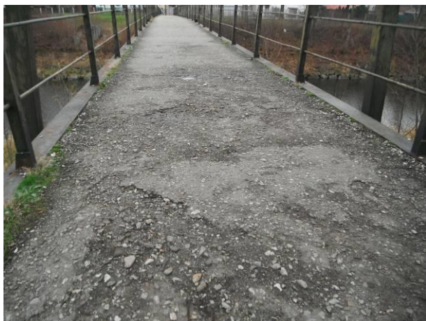
Na celé lávce je betonový povrch chodníku celoplošně degradován. Nacházejí se zde místa s vydroleným povrchem do hloubky cca 35 mm, ve kterých vznikají kaluže a zadržují vodu.
