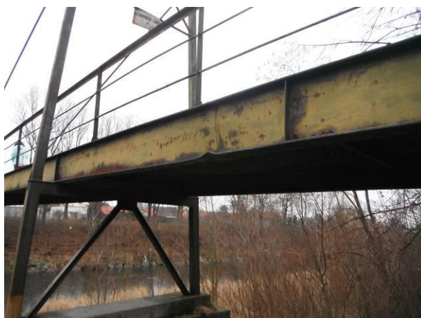
Ve 3. poli na pravé straně je mechanicky poškozen nosník.
