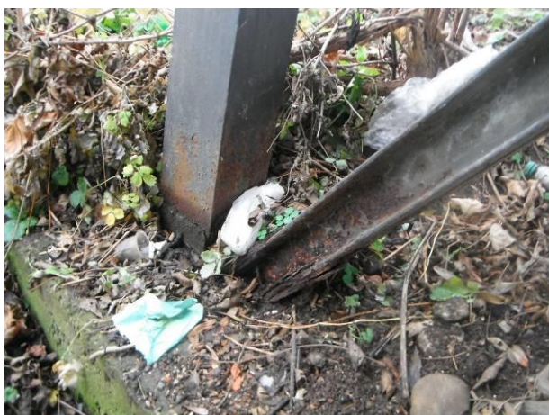
Pohled na P2, pravé kotvení. Značná lístková koroze v místě vetknutí podpěry do základu. Kotvení je částečně zasypáno – zvýšená vlhkost.
