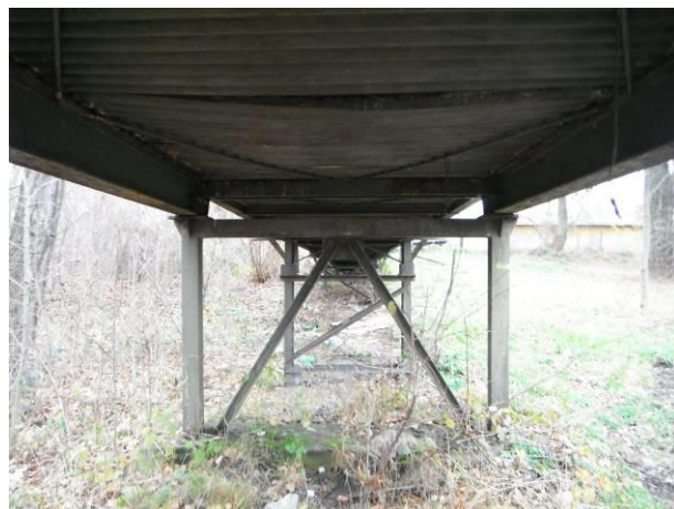
Pohled na poškozený vlněný plech (ztracené bednění mostovky) a P4.
