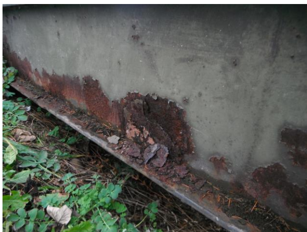
Detailní pohled na spodní přírubu hlavních nosníků NK. Nečistoty, koroze. Tento stav je na celé lávce.
