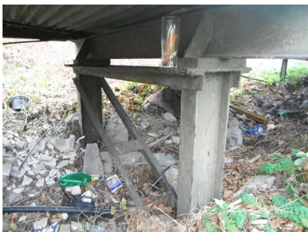
Pohled na P7, přesypáno kotvení sutí, nečistoty, vegetace.
