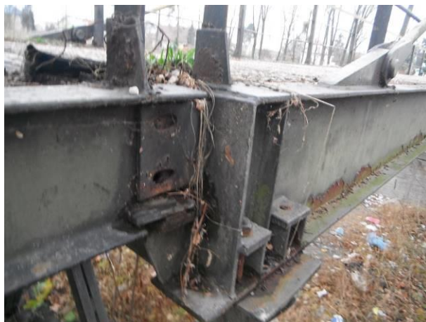
Pohled z levé strany - v kloubovém napojení rampy na lávku chybí spojovací šrouby, koroze všech oc. prvků lávky.
