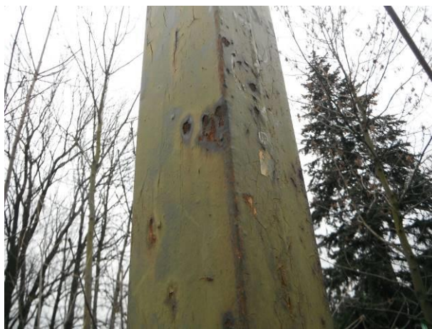
Detailní pohled na pylon P2 pravý, porucha PKO, koroze.
