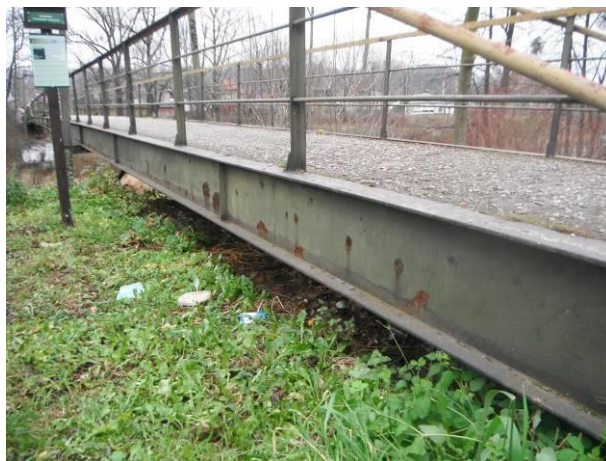
Pohled na spodní přírubu hlavních nosníků NK. Nečistoty, koroze. Tento stav je na celé lávce.
