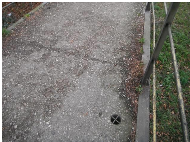
Prostup NK ve 4. až 7. poli je díky degradaci povrchu chodníku téměř nad povrchem okolních pochozích ploch.
