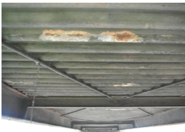
Detailní pohled - značná koroze vlněných plechů (ztracené bednění mostovky)
