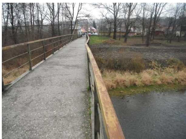
V 2. poli je poškozená pravá strana zábradlí.
