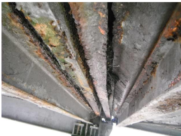
Pohled na P4 ze spodní strany, značná koroze vlněných plechů pod poškozenou dilatací.
