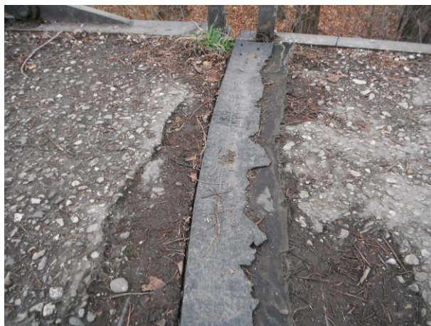
Mostní závěr mezi 3. a 4 polem je poškozen, nefunkční a částečně zanesen nečistotami.
