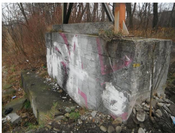
Pohled na základ a P3 z levého břehu od řeky. Obnažené pravé kotvení, vegetace.
