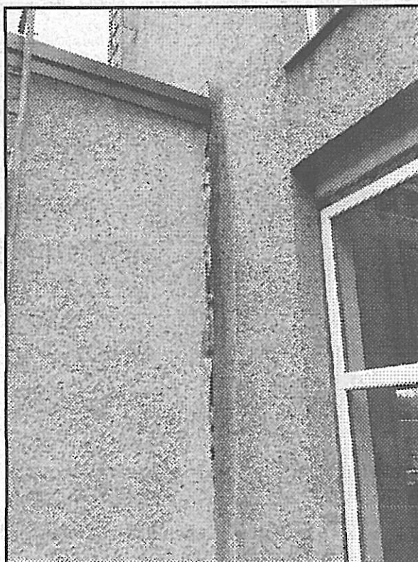
Obr. 4: Velká podélná škvíra se zbytky hnízdního materiálu pěvců na rozhraní západní strany budovy A a spojovacího krčku
