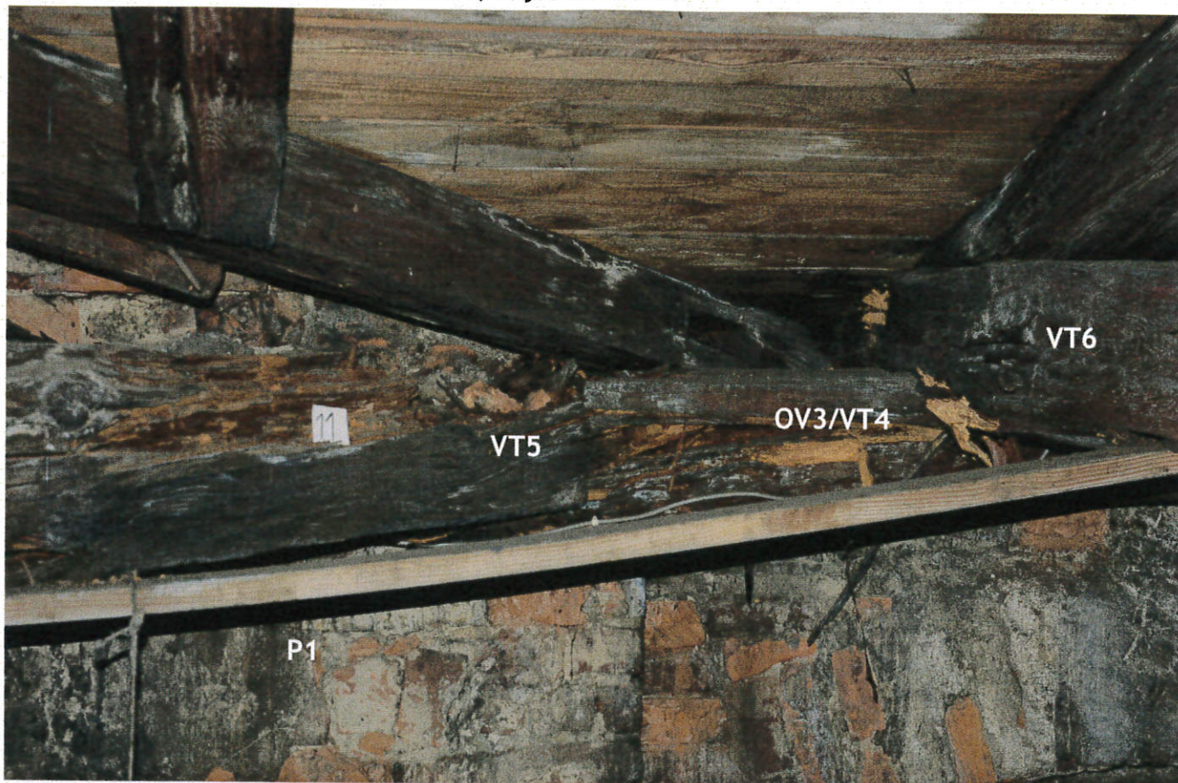
Obr. 1 Destruktivní poškození prvků krovu dřevokazným hmyzem čeledi ČERVOTOČOVITÝCH a dřevokaznou houbou třídy Basidiomycetes způsobující hnědou hnilobu. Stav po provedení kontrolních vpichů.
