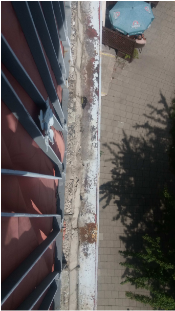
POHLED NA OPLECHOVÁNÍ BALKONU S CHYBĚJÍCÍ LIŠTOU NAHRAZENOU CEMENTOVOU MALTOU – BALKON B2
