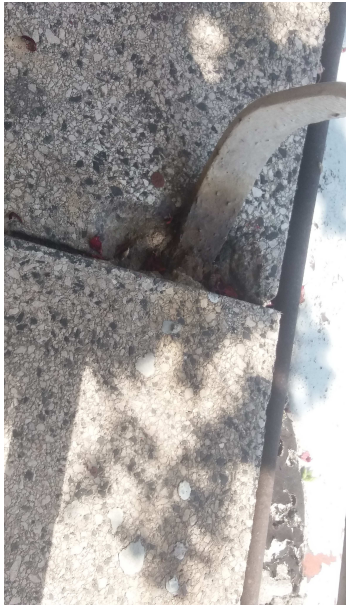
CHYBĚJÍCÍ DLAŽDICE A DEGRADOVANÁ MALTA BAKON B4 – 3.NP
