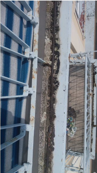
POHLED NA OPLECHOVÁNÍ BALKONU S DEGRADOVANOU LIŠTOU – BALKONŮ B1
