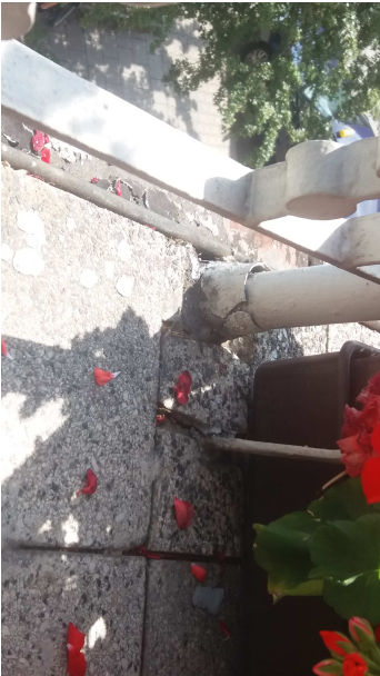
KOTVENÍ SLOUPKU ZABRADLÍ A POMOCNÉ PÁSOVINY SHORA DO PODLAHY BALKONŮ
