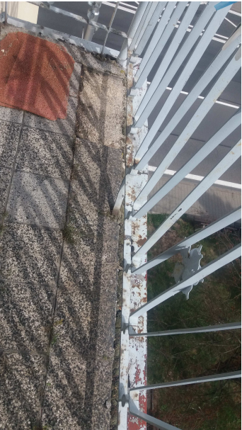
CHYBĚJÍCÍ DLAŽDICE A DEGRADOVANÁ MALTA BAKON B4 – 3.NP
