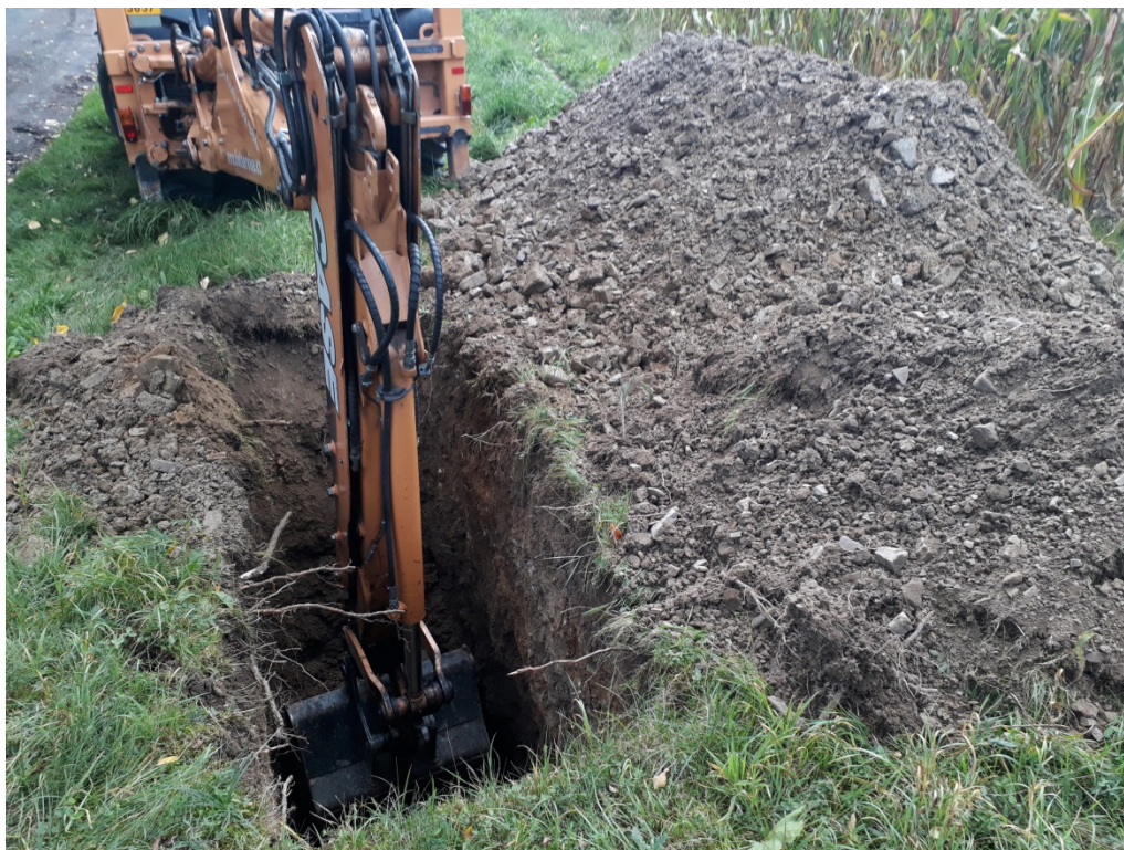
Obrázek 1 Realizace kopané sondy KS1
