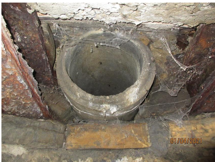
Pohled na potrubí nad lomem kamenné opěry v úrovni NK. V NK je vynechána kapsa, betonové potrubí DN 300.
