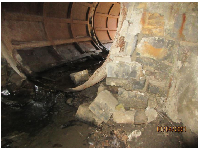
Rozpad kamenného zdiva, ve spodní části, v okolí ocelového potrubí.
