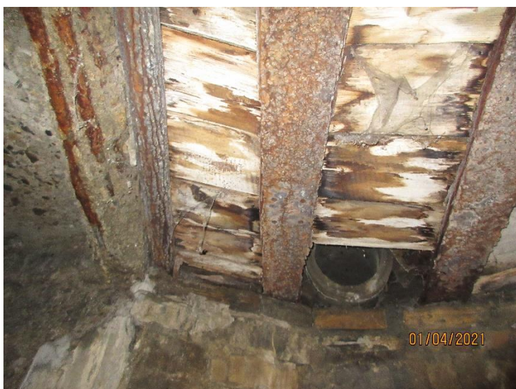
Nad kamennou částí jsou na podhledu NK vidět ocelové I profily, které značně korodují. Je ponecháno dřevěné bednění, které hnije a odpadává. Beton desky NK na obnažené části nejeví známky zásadních poruch.
