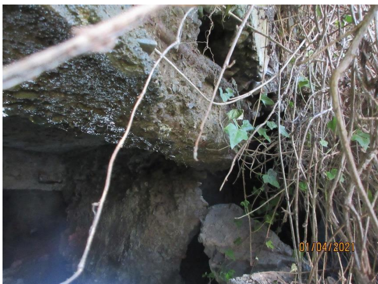
Roh OP2 i s částí křídla je na výtoku zcela zborcen. Zemina za opěrou, tvořící přechodovou oblast, je vysypána a tím vznikla kaverna hluboká cca 80cm.
