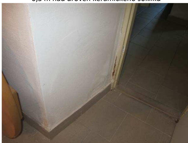
Foto č.28 – koroze kovových zárubní vlivem vysoké vnitřní relativní vlhkosti
