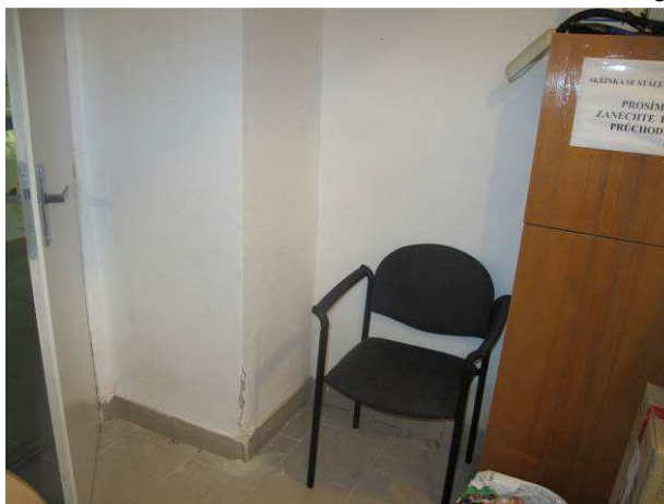
Foto č.26 – vnitřní stěny s projevy vlhkosti do výšky cca 0,5 m nad úroveň keramického soklíku
