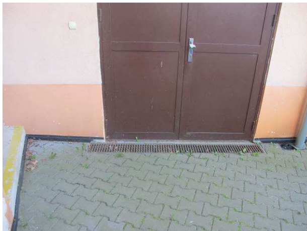
Foto č.14 – povrchový odvodňovací žlab u vstupu do novodobější přístavby (m.č. 013), dešťový svod osazen lapačem splavenin
