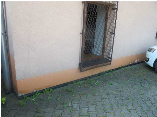
Foto č.13 – ukončovací lišta nopolové fólie (podél severní fasády), která odděluje konstrukční vrstvy vč. základby parkoviště od obvodového zdiva
