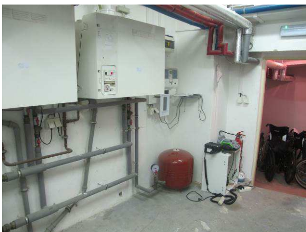
Foto č.33 – vnitřní stěna kotelny s vlhkostními projevy bezprostředně nad podlahou
