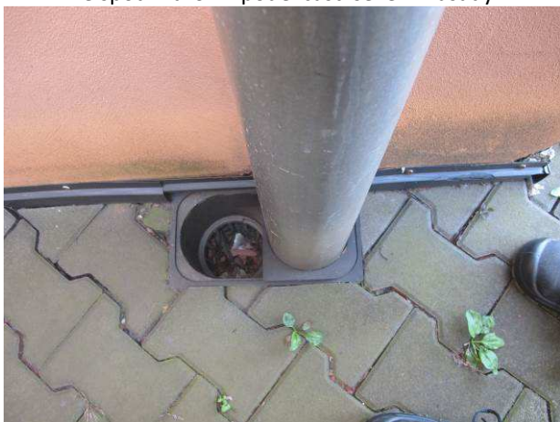
Foto č.11 – dešťový svod na severní straně osazen lapačem splavenin, který je však zcela ucpaný a tudíž při vydatnějších srážkách neplní svoji funkci
