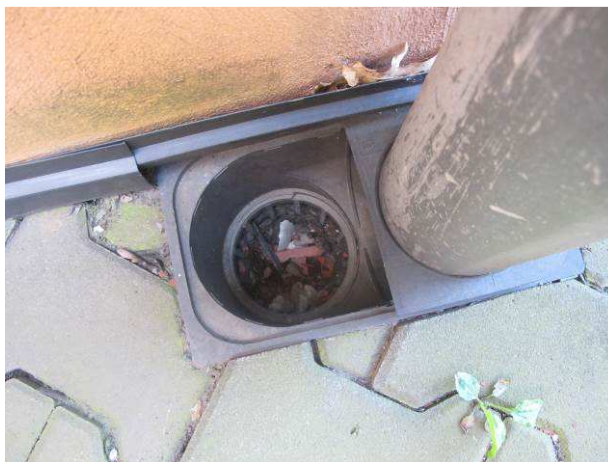
Foto č.12 – detail ucpaného lapače splavenin
