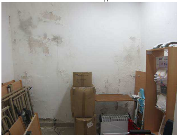
Foto č.24 – degradace omítek v plném rozsahu na uliční jižní obvodové stěně v m.č. 006
