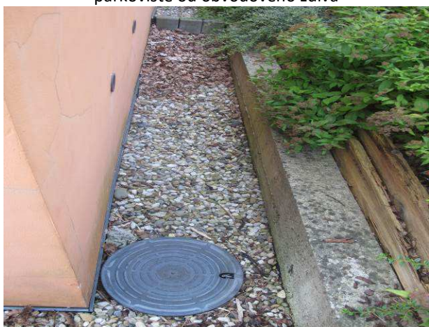
Foto č.15 – štěrkový obsyp po severním a západním obvodu přístavby a západním obvodu hlavní budovy, kanalizační šachta nově provedené dešťové kanalizace u severozápadního nároží přístavby
