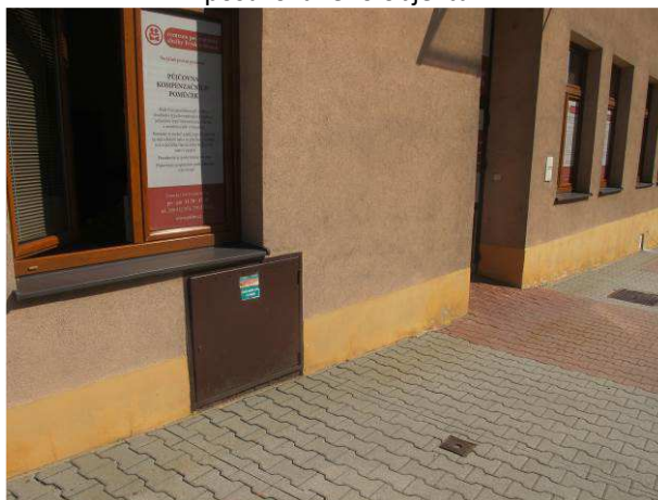
Foto č.4 – charakter zpevněné plochy z uliční strany, projevy vlhkosti na uliční fasádě v soklové části bezprostředně nad stávajícím chodníkem
