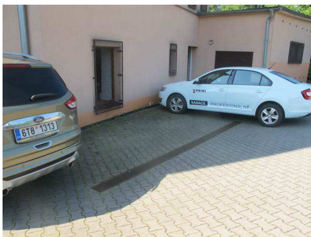
Foto č.10 – detailní pohled na povrchový odvodňovací žlab podél části severní fasády ve vzdálenosti cca 1,2 – 1,5 m od obvodového zdiva
