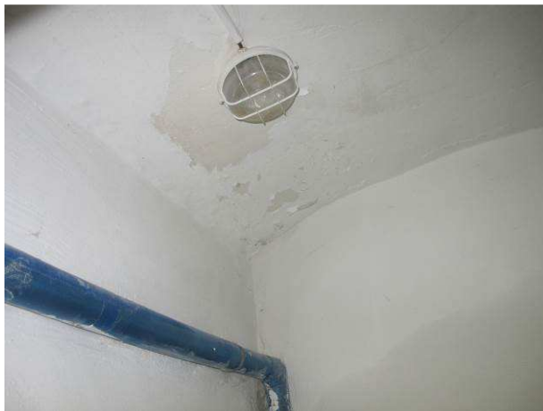
Foto č.30 – přetahující se vlhkost do klenby z uliční obvodové stěny v m.č. 004 (TZB)
