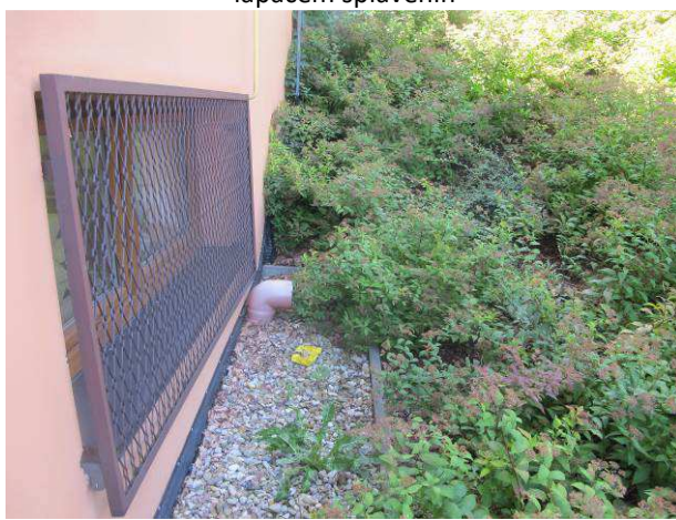
Foto č.16 – odvětrávání z kotleny pomocí plastové roury vyvedené nad úroveň štěrkového obsypu
