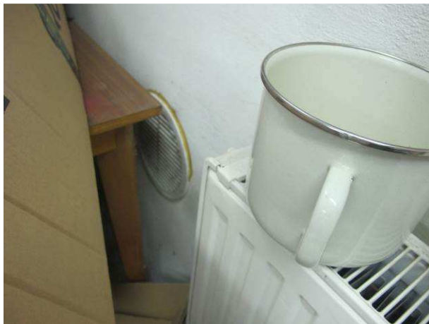
Foto č.32 – odvětrání kotelny přes západní obvodovou stěnu, v době průzkumu však zcela zaskládané, a tudíž s velmi omezenou funkcí
