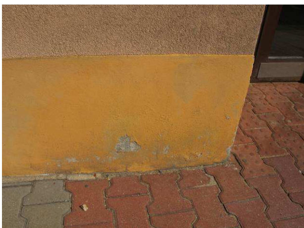
Foto č.5 – povrchové úpravy v soklové části vyztužené perlinkou
