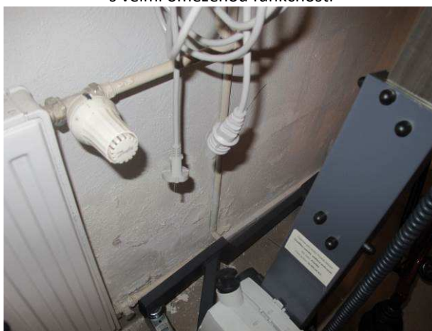
Foto č.34 – západní obvodová stěna v m.č. 002 se spráskáním povrchů a solnými výkvěty
