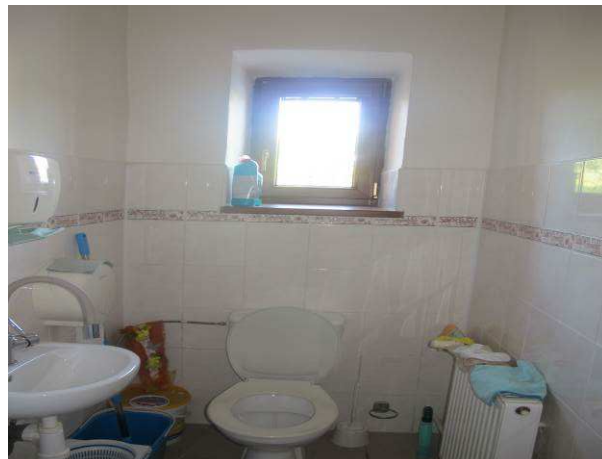
Foto č.20 – prostor sociálního zázemí (m.č. 010) s keramickým obkladem na výšku 1,6 m
