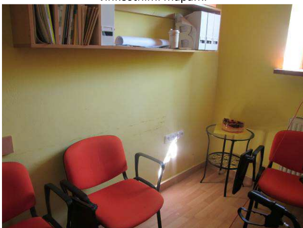
Foto č.21 – sprášování povrchových úprav se solnými výkvěty na severní obvodové stěně v m.č. 008
