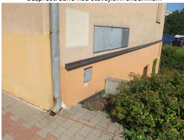
Foto č.6 – dešťový svod z uliční strany zaústěn do lapače splavenin
