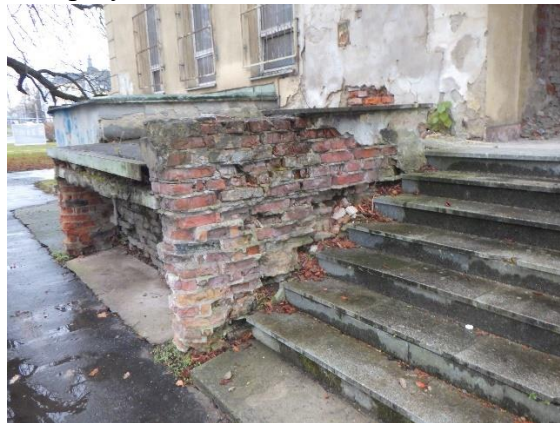
Foto č. 227 - 228 – Poruchy – poškození zdiva z děrovaných cihel u rampa
