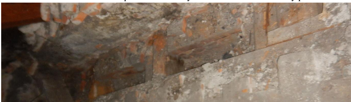
Foto č. 135 – sonda NV26 – stropní dřevěné trámy uložené na zdivo – celkový pohled
