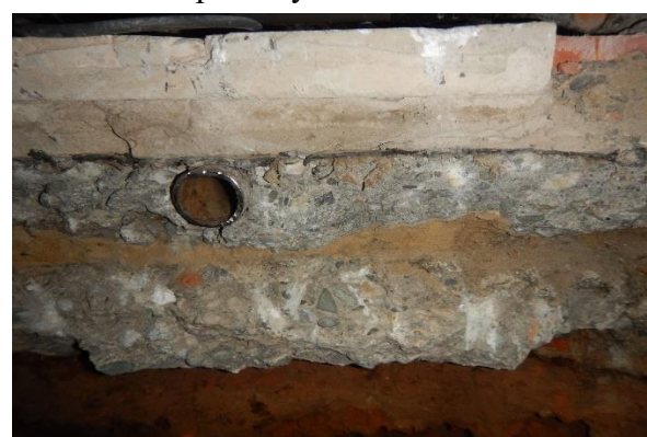
- Kamenný základ s cihelnou nadezdívkou skladba podlahy
