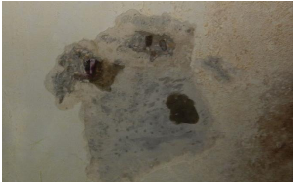
Foto č. 111 -112 – sonda NV18 – strop z žb panelů, nedestruktivní zkoušky pevnosti betonu
