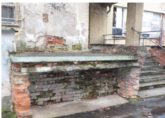
Foto č. 227 - 228 – Poruchy – poškození zdiva z děrovaných cihel u rampa
