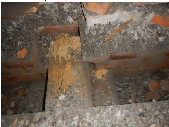
Foto č. 148 - 151 – sonda NS 38-41 – nefunkční ztužení obvodové stěny
