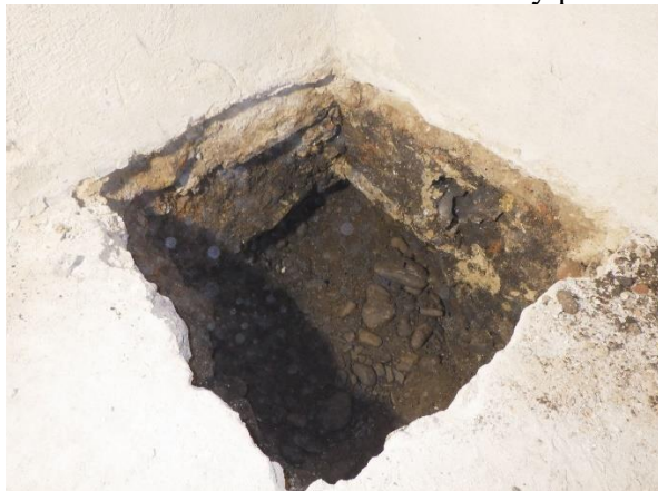
Foto č. 13 - 16 – sonda K 5 – celkový pohled výkopek – násyp štěrk se stavební sutí
