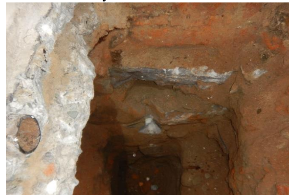
- Kamenný základ s cihelnou nadezdívkou skladba podlahy
