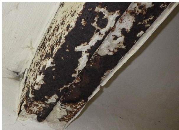
Foto č. 91 - 92 – sonda NV11– pohled na strop-žb panel, detail výztuže PZD desky
