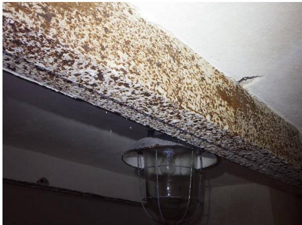
Foto č. 91 - 92 – sonda NV11– pohled na strop-žb panel, detail výztuže PZD desky
