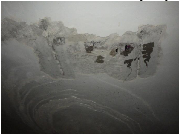
Foto č. 99 - 100 – sonda NV14 – strop z žb panelů, detail výztuže
