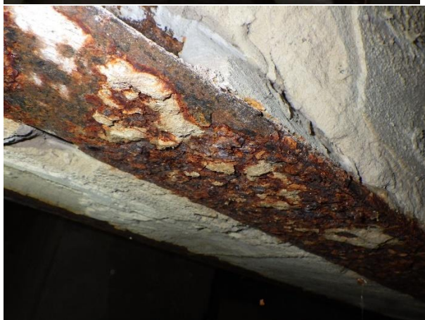
sonda NV19/2 - strop z žb panelů, detail výztuže a zkouška karbonatace
