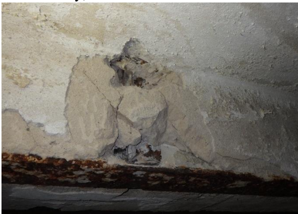
Foto č. 113 -118 – sonda NV19/1 – stropní ocelové nosníky, koroze nosníků v sondě
