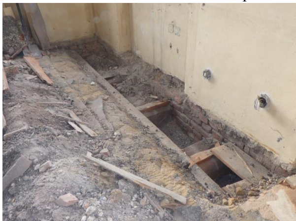
Foto č. 129 -134 – sonda NV24 – stropní dřevěné trámy uložené do zdiva
