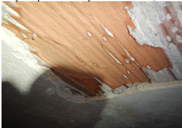
Foto č. 105-108 – sonda NV16 – pohled poškozený strop z keramických desek hurdis,
