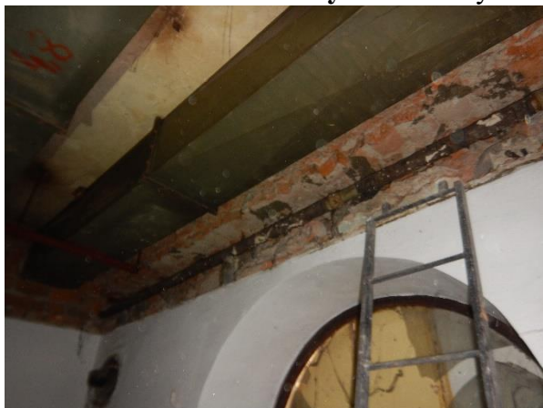
Foto č. 186 - 187 – Poruchy v 1.NP – trhliny mezi nosnou zdí a stropní konstrukcí
