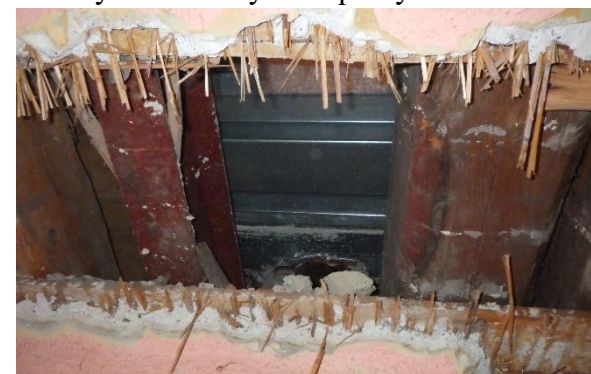
Foto č. 125 -128 – sonda NV23 – stropní dřevěné trámy s vloženým rozpěrným I nosníkem
