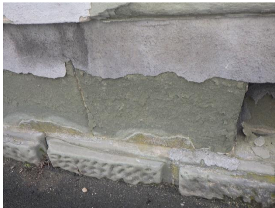
Foto č. 225 - 226 – Poruchy – poškození zdiva z plných cihel u venkovního schodiště
