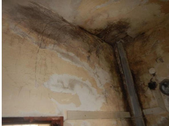
Foto č. 190 - 191 – Poruchy v 1.NP – prorůstání hub a kořenů v místě bývalého zatékání
