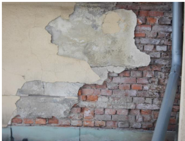
Foto č. 214 - 215 – Poruchy – poškozený sokl zdiva 1.NP sálu na SZ straně
