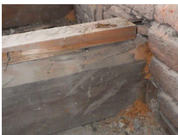
Foto č. 135 – sonda NV26 – stropní dřevěné trámy uložené na zdivo – celkový pohled
