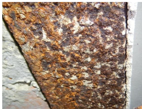
detail důlkové koroze I nosníku
