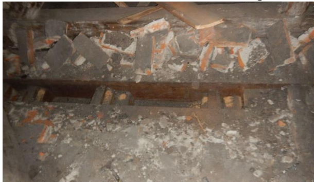
Foto č. 140 - 143 – sonda NV27 – stropní dřevěné trámy uložené do I nosníku, T1 a R1
