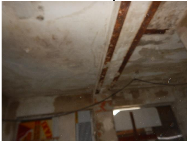
Foto č. 182 - 183 – Poruchy v 1.NP – velmi silná koroze ocelových nosníků
