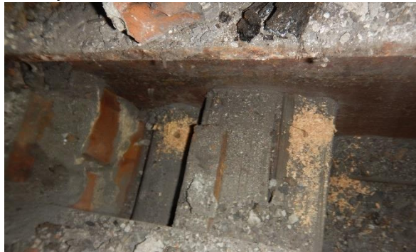
Foto č. 140 - 143 – sonda NV27 – stropní dřevěné trámy uložené do I nosníku, T1 a R1
