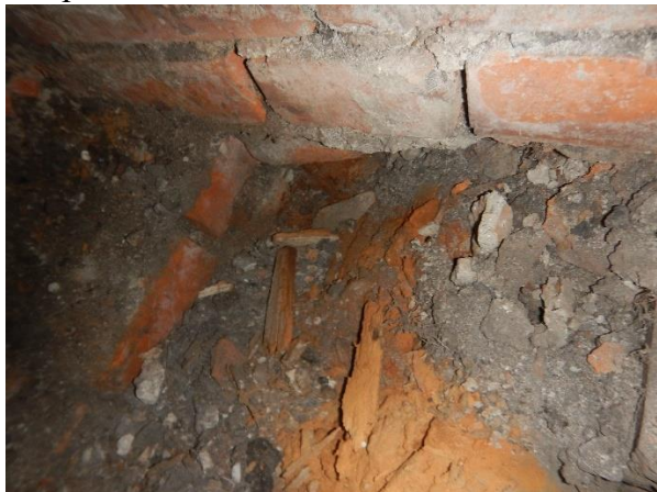
Foto č. 136 - 139 – sonda NV26 – stropní dřevěné trámy
