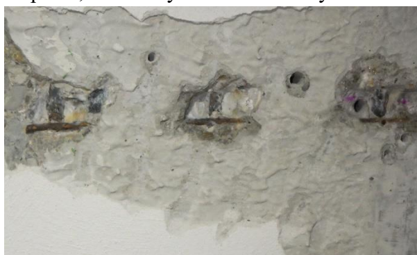
Foto č. 93 - 94 – sonda NV12/1– pohled na strop-žb panel, detail výztuže PZD desky
