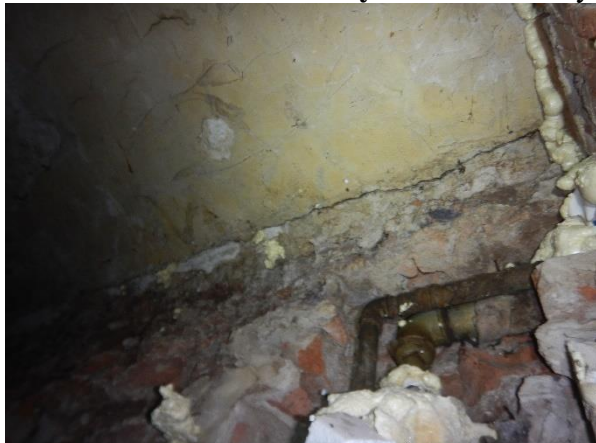
Foto č. 188 - 189 – Poruchy v 1.NP – narušená keramika hurdis tvarovek a opadávání omítek
