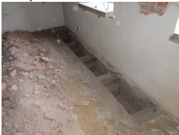
Foto č. 119 -120 – sonda NV21 – stropní dřevěné trámy uložené do zdiva
