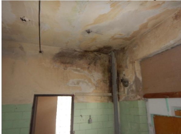
Foto č. 190 - 191 – Poruchy v 1.NP – prorůstání hub a kořenů v místě bývalého zatékání
