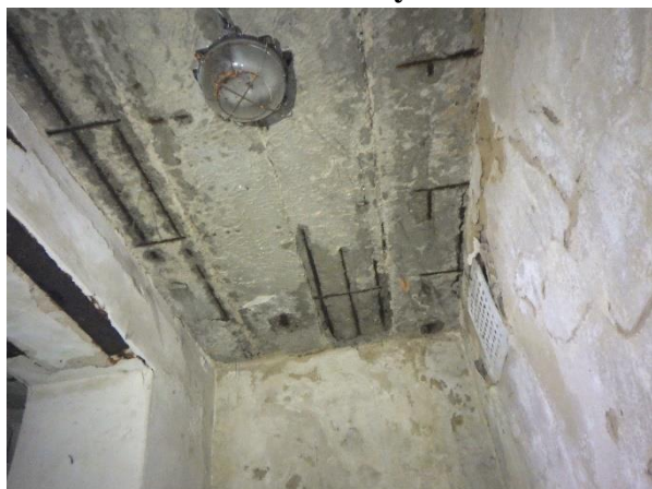
Foto č. 160 - 163 – Poruchy v 1.PP – velmi silná koroze ocelových výztuží a nosníků
