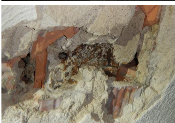
Foto č. 109 -110 – sonda NV17 – strop z žb panelů, detail výztuže a zkouška karbonatace
