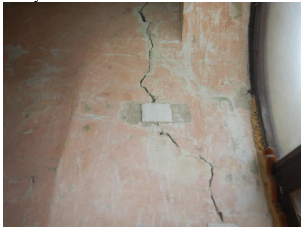
Foto č. 164 - 167 – Poruchy v 1.NP – statické trhliny mezi obvodovou a vnitřní nosnou zdí
