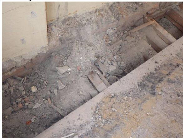
Foto č. 129 -134 – sonda NV24 – stropní dřevěné trámy uložené do zdiva
