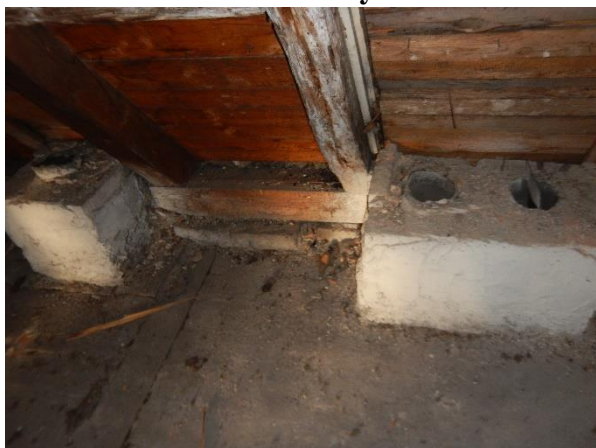
Foto č. 204 - 207 – Poruchy v 2.NP – nalezení azbestových trub ve starých komínech
