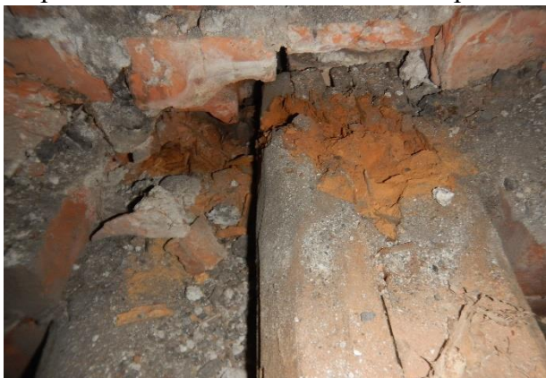
Foto č. 140 - 143 – sonda NV27 – stropní dřevěné trámy uložené do I nosníku, T1 a R1
