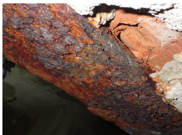
sonda NV19/2 - strop z žb panelů, detail výztuže a zkouška karbonatace
