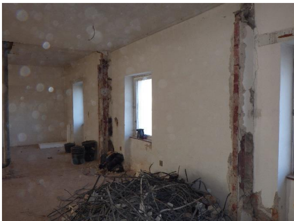
Foto č. 148 - 151 – sonda NS 38-41 – nefunkční ztužení obvodové stěny
