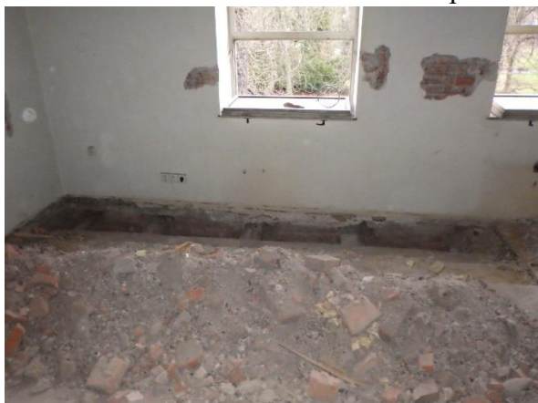
Foto č. 119 -120 – sonda NV21 – stropní dřevěné trámy uložené do zdiva
