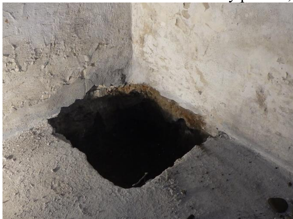
Foto č. 11 - 12 – sonda K 4 – celkový pohled , základová spára a štěrková
