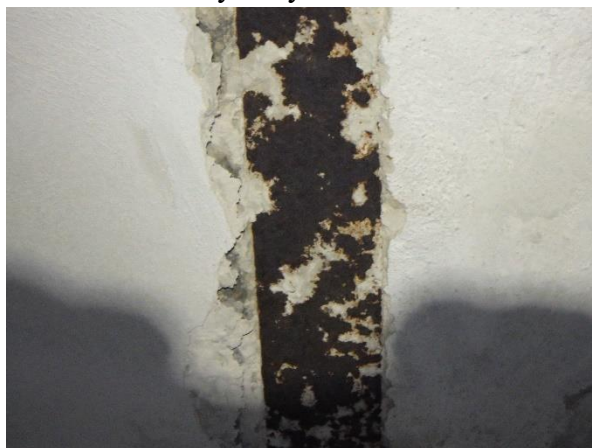
Foto č. 160 - 163 – Poruchy v 1.PP – velmi silná koroze ocelových výztuží a nosníků
