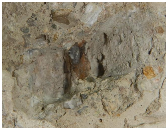
detail důlkové koroze I nosníku
