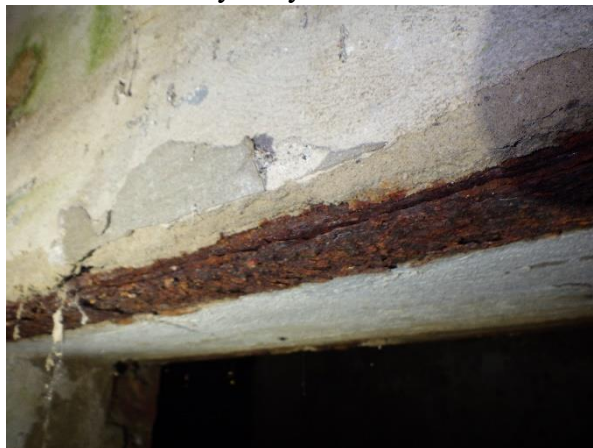
Foto č. 156 - 159 – Poruchy v 1.PP – velmi silná koroze ocelových výztuží a nosníků
