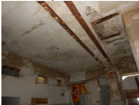
Foto č. 182 - 183 – Poruchy v 1.NP – velmi silná koroze ocelových nosníků
