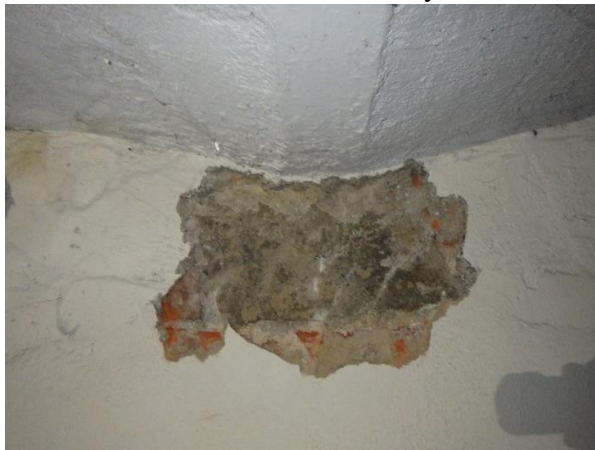
- spodní pásnice I nosníku
