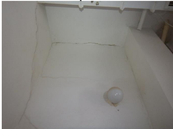
Foto č. 188 - 189 – Poruchy v 1.NP – narušená keramika hurdis tvarovek a opadávání omítek
