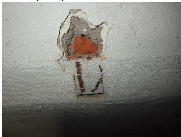
- spodní pásnice I nosníku
