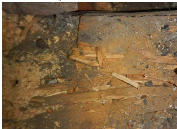
Foto č. 148 - 151 – sonda NS 38-41 – nefunkční ztužení obvodové stěny
