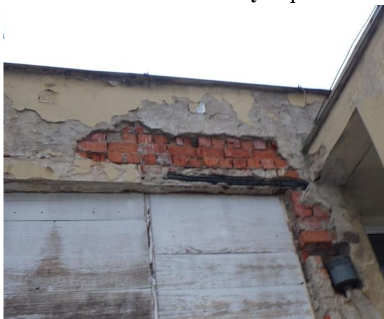
Foto č. 229 - 230 – Poruchy – poškození zdiva obvodového zdiva z děrovaných cihel
