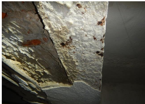
Foto č. 87 - 88 – sonda NV10/1 – pohled na strop-žb panel, detail výztuže PZD desky a dutiny
