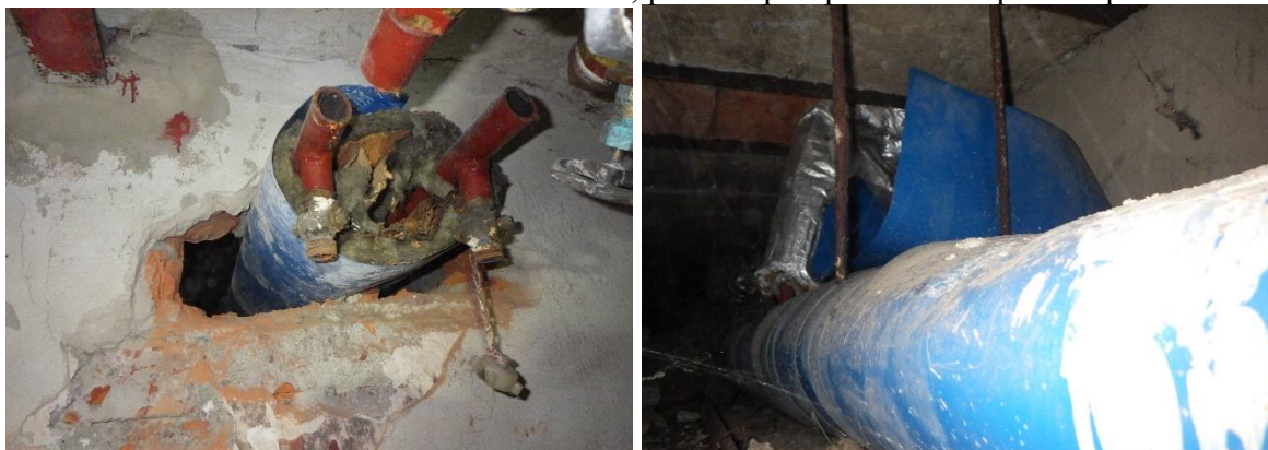
Foto č. 57 - 60 – kanál ÚT – zaústění v 1.PP, probíhá pod podlahou nepodsklepené části 1.NP
