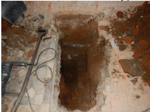
- Kamenný základ s cihelnou nadezdívkou skladba podlahy
