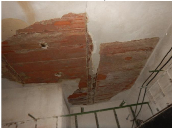
Foto č. 190 - 191 – Poruchy v 1.NP – prorůstání hub a kořenů v místě bývalého zatékání
