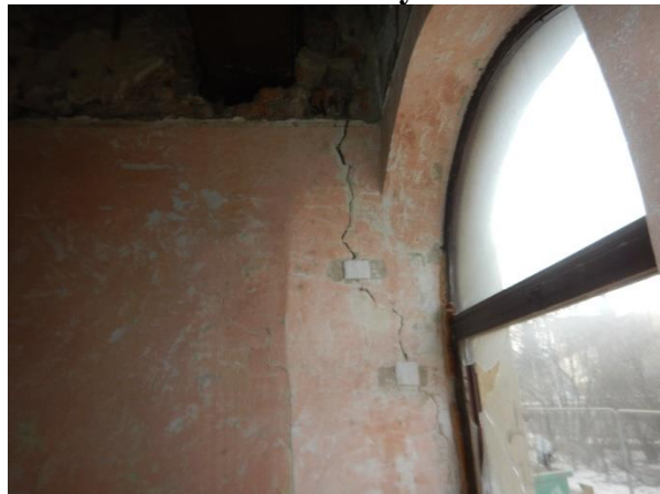
Foto č. 164 - 167 – Poruchy v 1.NP – statické trhliny mezi obvodovou a vnitřní nosnou zdí
