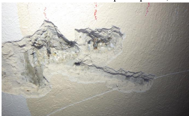
- sonda NV15/2 – strop z žb panelů,
