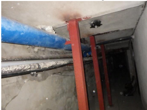
Foto č. 75 - 80 – sonda NV5 – pohled na strop v místě podepření nosníků pomocí L
