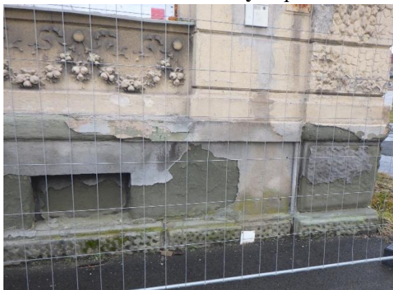
Foto č. 225 - 226 – Poruchy – poškození zdiva z plných cihel u venkovního schodiště
