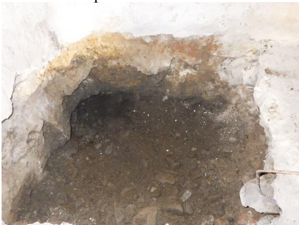
Foto č. 11 - 12 – sonda K 4 – celkový pohled , základová spára a štěrková
