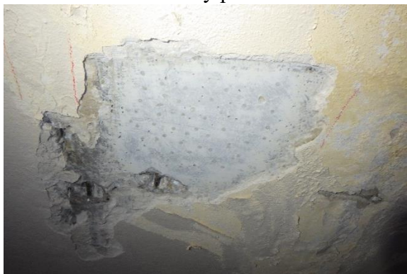
Foto č. 111 -112 – sonda NV18 – strop z žb panelů, nedestruktivní zkoušky pevnosti betonu
