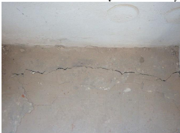
Foto č. 202 - 203 – Poruchy v 2.NP – trhliny v podlaze u obvodové severozápadní stěny
