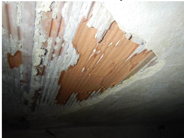
Foto č. 190 - 191 – Poruchy v 1.NP – prorůstání hub a kořenů v místě bývalého zatékání
