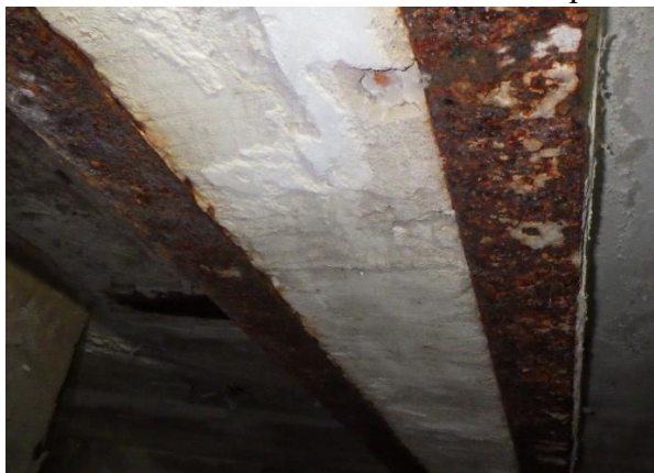
Foto č. 113 -118 – sonda NV19/1 – stropní ocelové nosníky, koroze nosníků v sondě
