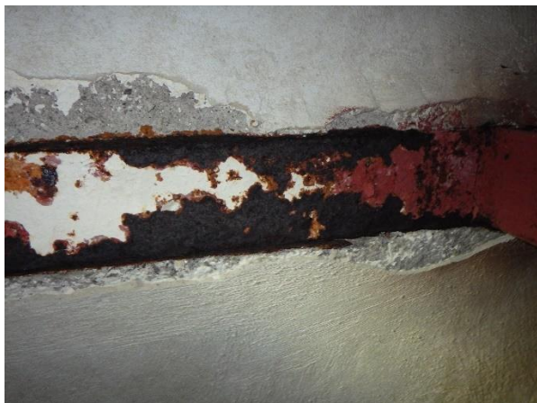
Foto č. 75 - 80 – sonda NV5 – pohled na strop v místě podepření nosníků pomocí L
