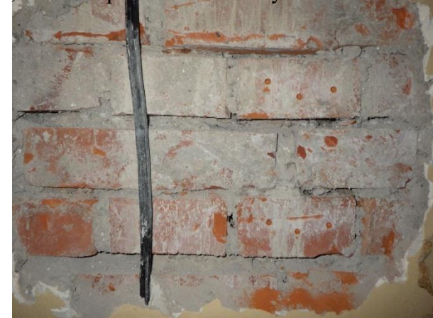
Foto č. 47 - 48 – sonda NS 22 – celkový pohled , detail provedené zkoušky
