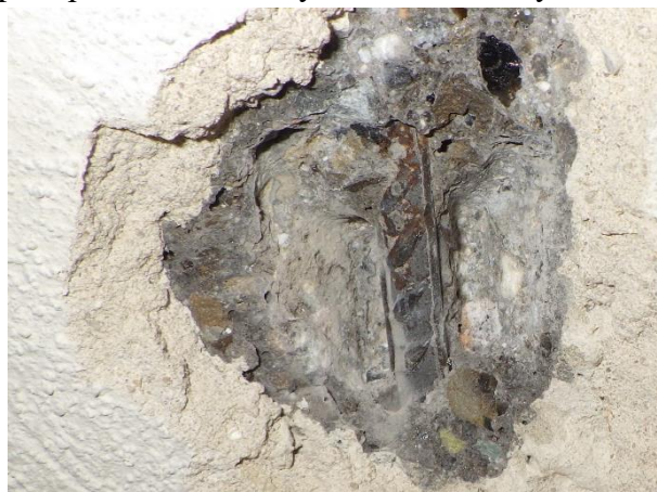
Foto č. 95 - 96 – sonda NV12/2– stropní ocelové nosníky, koroze jednoho nosníku v sondě
