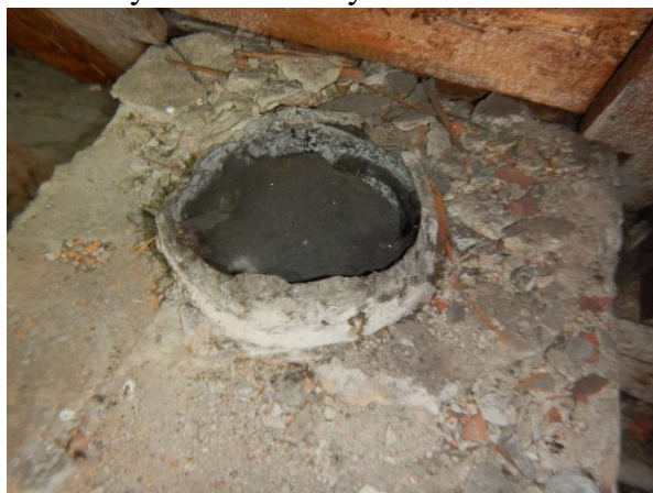
Foto č. 204 - 207 – Poruchy v 2.NP – nalezení azbestových trub ve starých komínech
