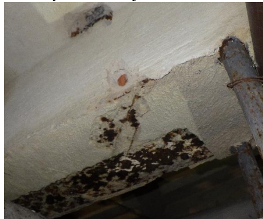
Foto č. 95 - 96 – sonda NV12/2– stropní ocelové nosníky, koroze jednoho nosníku v sondě
