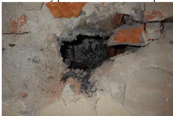
Foto č. 53 - 54 – sonda NS 26 – celkový pohled , komínový průduch u sondy
