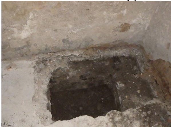
- HI a betonový práh na kamenném základu
