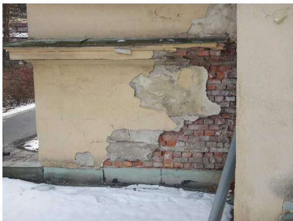
Foto č. 214 - 215 – Poruchy – poškozený sokl zdiva 1.NP sálu na SZ straně
