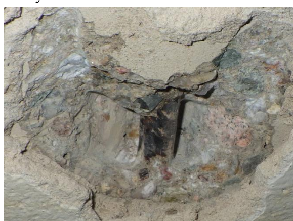
Foto č. 119 -120 – sonda NV21 – stropní dřevěné trámy uložené do zdiva
