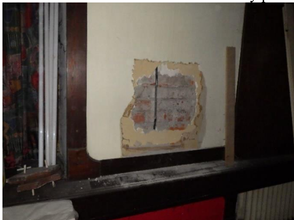
Foto č. 47 - 48 – sonda NS 22 – celkový pohled , detail provedené zkoušky
