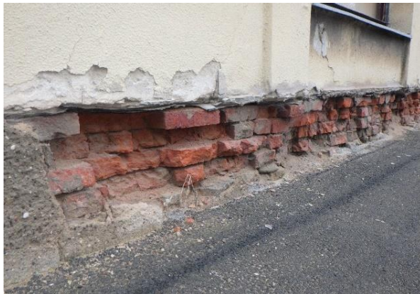
Foto č. 214 - 215 – Poruchy – poškozený sokl zdiva 1.NP sálu na SZ straně
