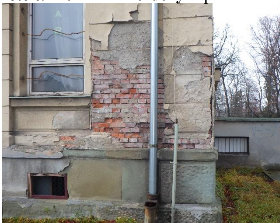
Foto č. 216 - 222 – Poruchy – poškozené omítky a zdivo na historické části objektu
