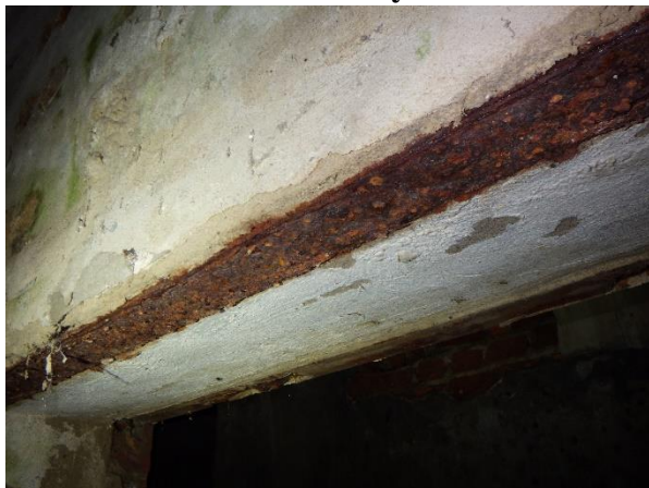
Foto č. 156 - 159 – Poruchy v 1.PP – velmi silná koroze ocelových výztuží a nosníků
