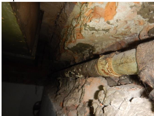
Foto č. 186 - 187 – Poruchy v 1.NP – trhliny mezi nosnou zdí a stropní konstrukcí
