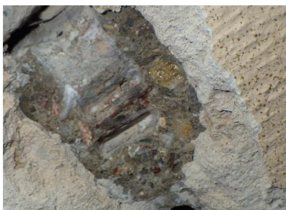
Foto č. 101-104 – sonda NV15/1 – stropní ocelové nosníky, koroze nosníků v sondě
