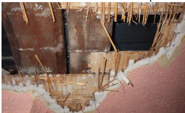
Foto č. 125 -128 – sonda NV23 – stropní dřevěné trámy s vloženým rozpěrným I nosníkem
