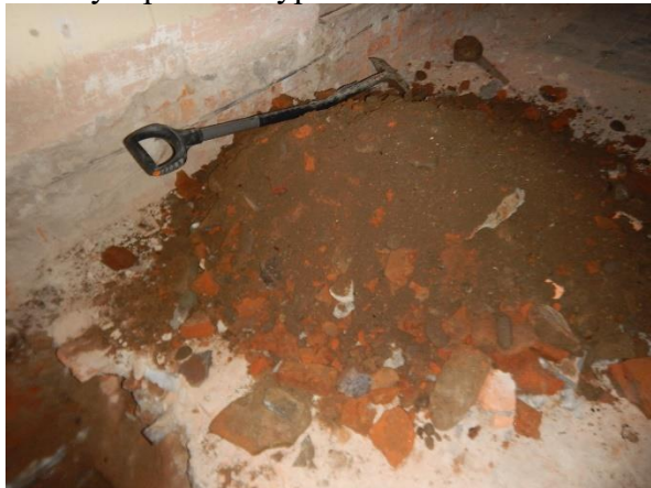
- Kamenný základ s cihelnou nadezdívkou skladba podlahy
