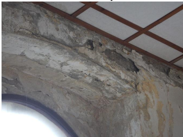
Foto č. 176 - 181 – Poruchy v 1.NP – místa narušené vlhkostí po zatékáním
