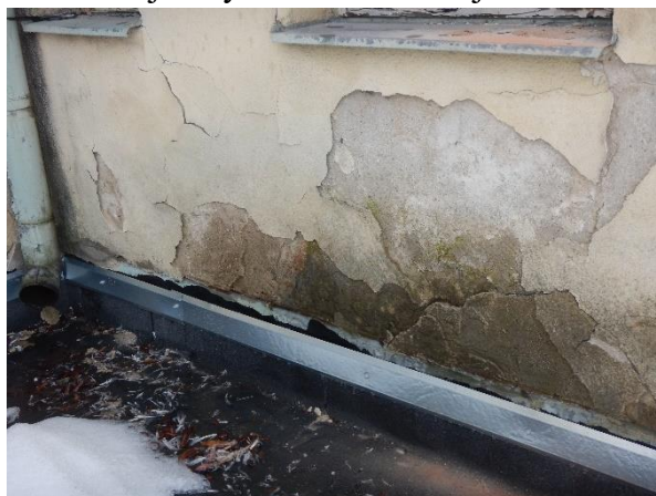
Foto č. 208 - 213 – Poruchy v 2.NP – opadání omítek na jihovýchodní straně objektu
