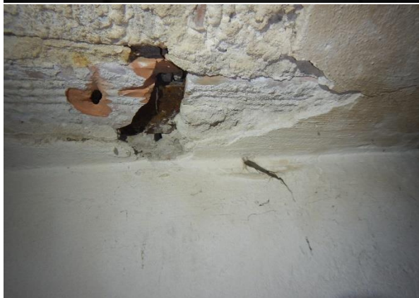
Foto č. 109 -110 – sonda NV17 – strop z žb panelů, detail výztuže a zkouška karbonatace
