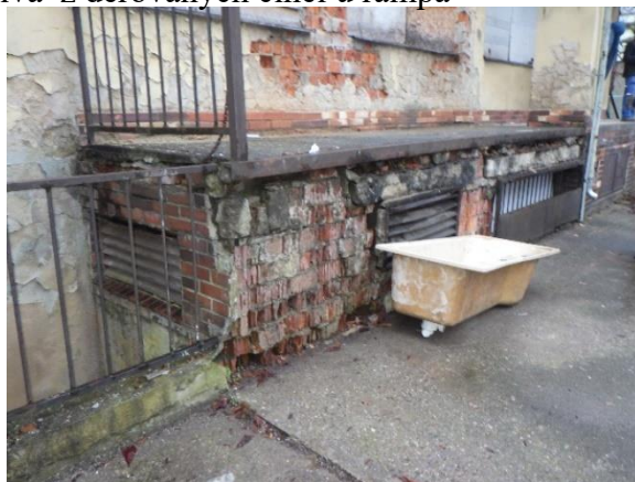
Foto č. 229 - 230 – Poruchy – poškození zdiva obvodového zdiva z děrovaných cihel
