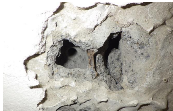
Foto č. 87 - 88 – sonda NV10/1 – pohled na strop-žb panel, detail výztuže PZD desky a dutiny
