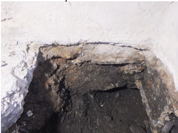
Foto č. 13 - 16 – sonda K 5 – celkový pohled výkopek – násyp štěrk se stavební sutí
