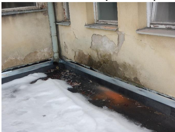
Foto č. 208 - 213 – Poruchy v 2.NP – opadání omítek na jihovýchodní straně objektu
