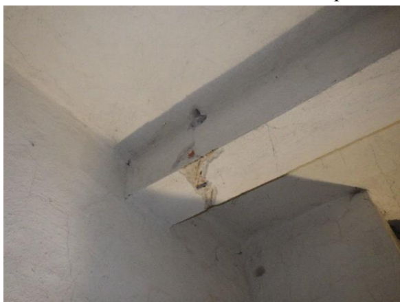
Foto č. 95 - 96 – sonda NV12/2– stropní ocelové nosníky, koroze jednoho nosníku v sondě
