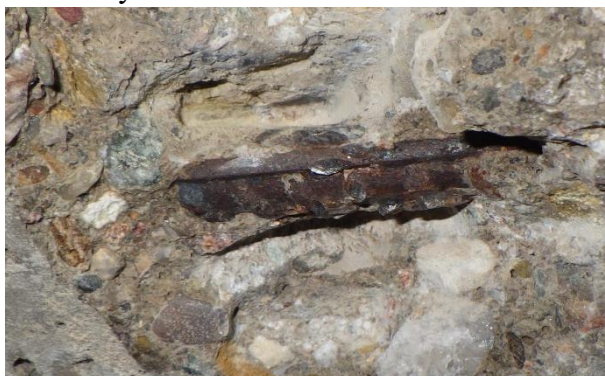
detail výztuže a zkouška karbonatace
