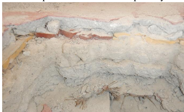
Foto č. 125 -128 – sonda NV23 – stropní dřevěné trámy s vloženým rozpěrným I nosníkem
