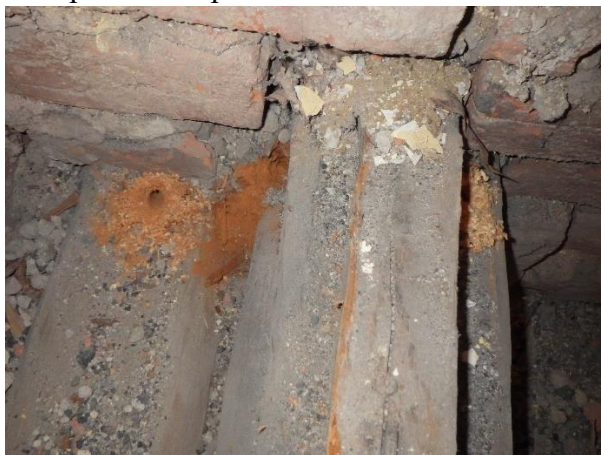
Foto č. 135 – sonda NV26 – stropní dřevěné trámy uložené na zdivo – celkový pohled
