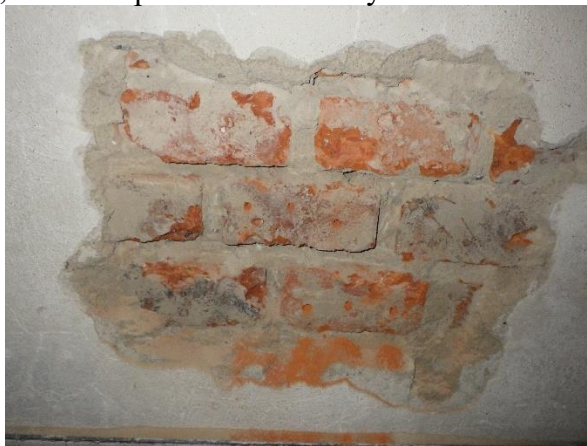
Foto č. 43 - 44 – sonda NS 11 – celkový pohled , detail provedené zkoušky
