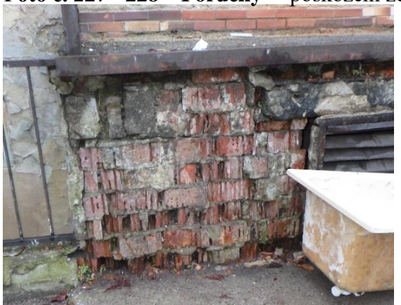
Foto č. 229 - 230 – Poruchy – poškození zdiva obvodového zdiva z děrovaných cihel
