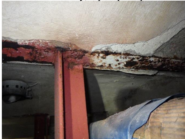
Foto č. 75 - 80 – sonda NV5 – pohled na strop v místě podepření nosníků pomocí L
