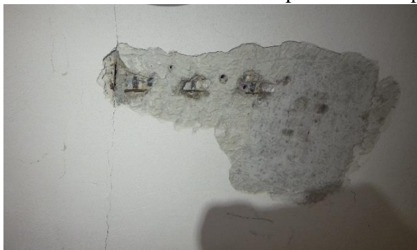
Foto č. 93 - 94 – sonda NV12/1– pohled na strop-žb panel, detail výztuže PZD desky
