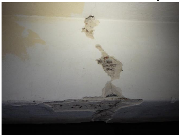
- sonda NV15/2 – strop z žb panelů,
