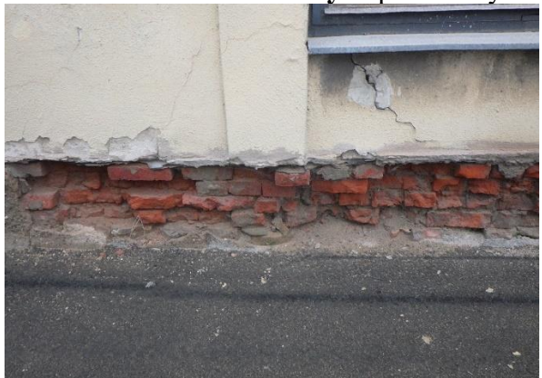
Foto č. 214 - 215 – Poruchy – poškozený sokl zdiva 1.NP sálu na SZ straně
