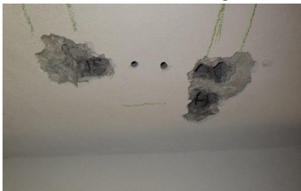
Foto č. 87 - 88 – sonda NV10/1 – pohled na strop-žb panel, detail výztuže PZD desky a dutiny
