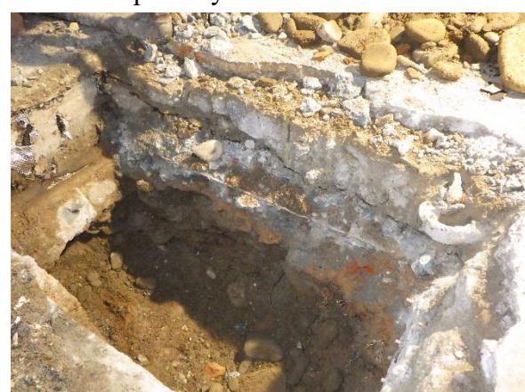
- základ pod střední stěnou K2/2
