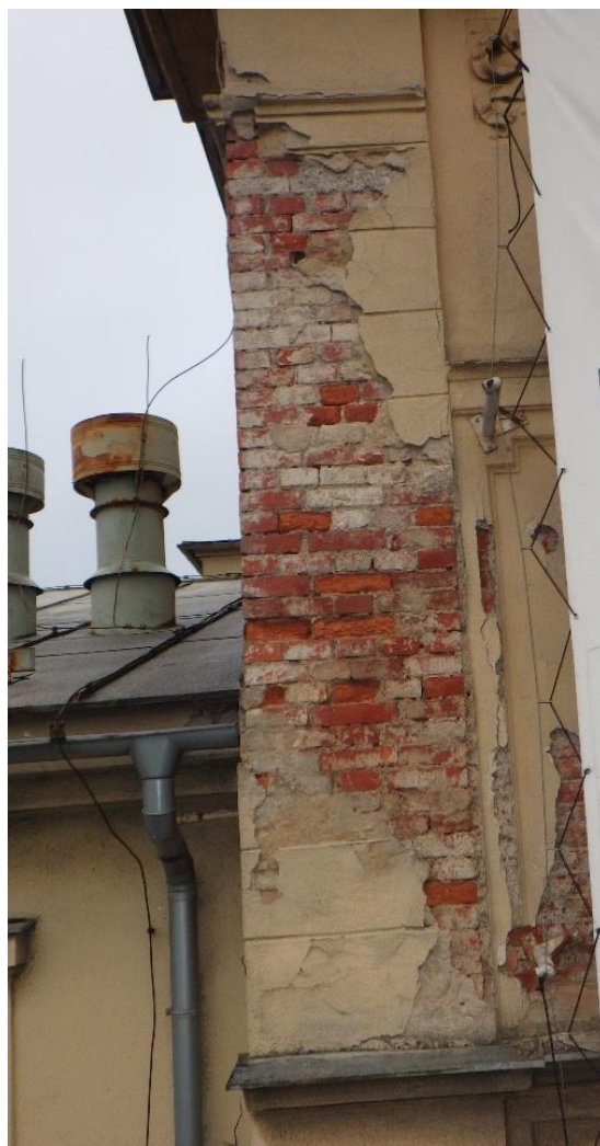
Foto č. 216 - 222 – Poruchy – poškozené omítky a zdivo na historické části objektu
