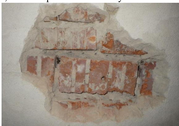
Foto č. 45 - 46 – sonda NS 17 – celkový pohled , detail provedené zkoušky
