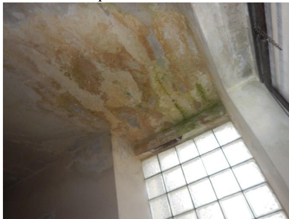
Foto č. 176 - 181 – Poruchy v 1.NP – místa narušené vlhkostí po zatékáním
