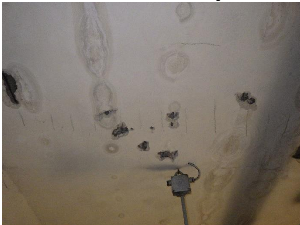
Foto č. 95 - 96 – sonda NV12/2– stropní ocelové nosníky, koroze jednoho nosníku v sondě
