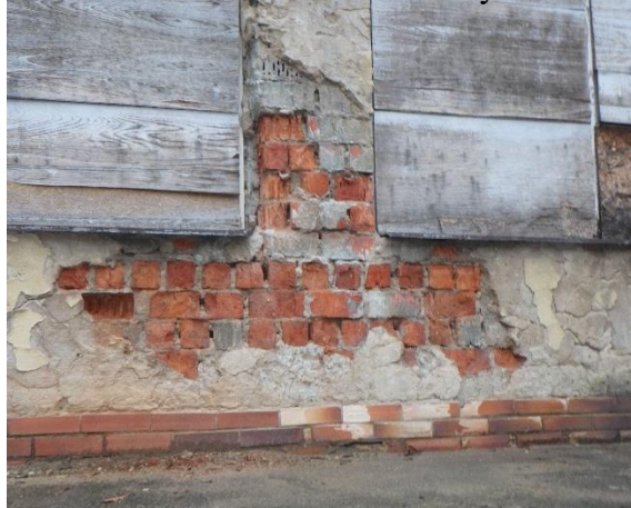
Foto č. 229 - 230 – Poruchy – poškození zdiva obvodového zdiva z děrovaných cihel
